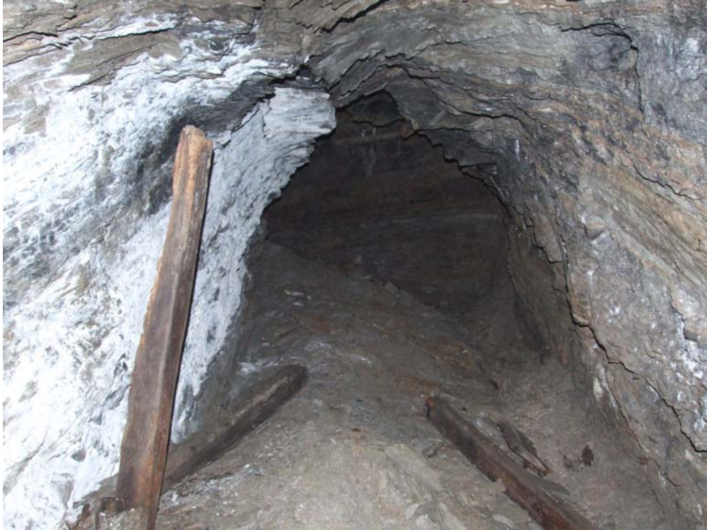
Sl. 32 Nepodgrađeni dio starog podzemnog tunela KTK prije sanacije (novembar 2006.)
